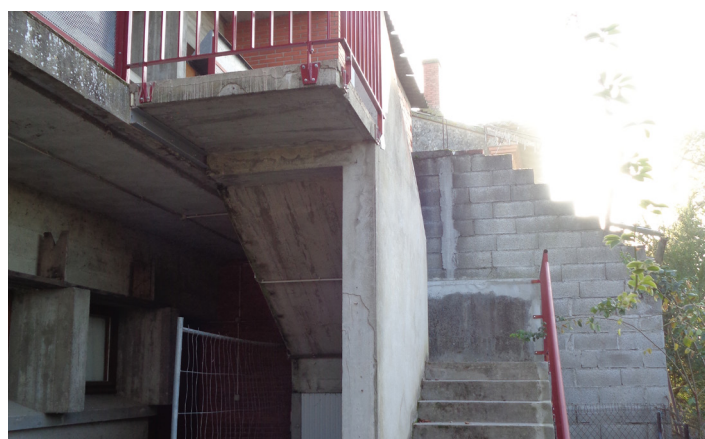
Escalier de secours foyer rural
