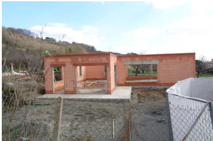
• Élévation des murs extérieurs
