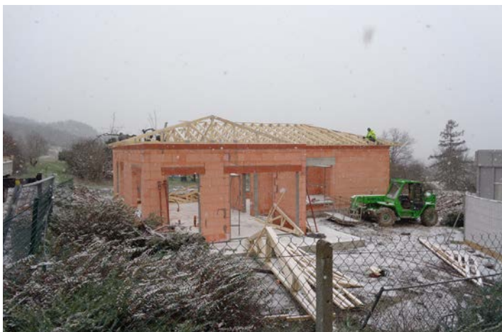
• Vue d'ensemble du bâtiment
